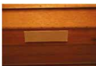
Ein Stück Pappe, Holz oder der Teil eines Fahrradschlauches wird zum Abdecken des Risses verwendet.
