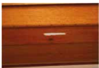
Der Riss ist lokalisiert
