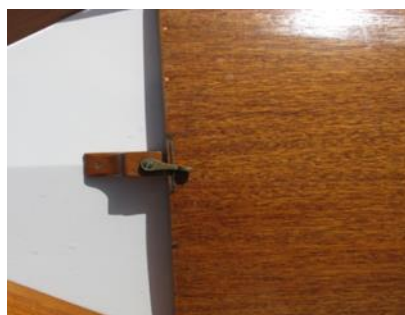
De gamle vingebeslag skal efterspændes. De er tit for løse.
