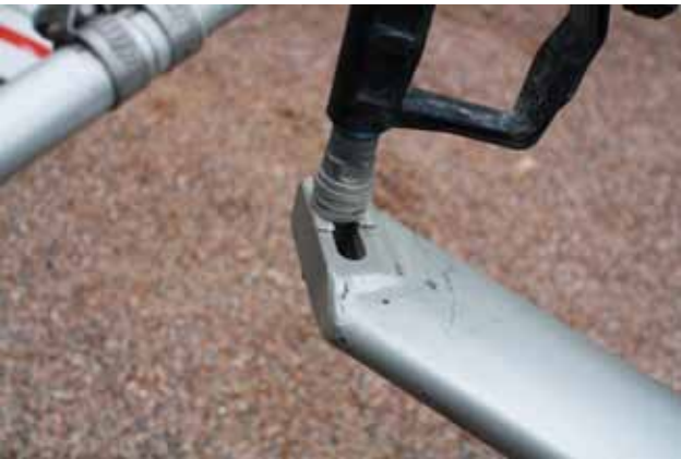
Justering af udadhældning med dåsefolie.
